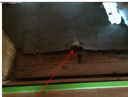
Bild 18: Prov 27, Lumppapp med tjära, kryptrymme fritidsrum plan 2. 21 mg/kg PAH.
