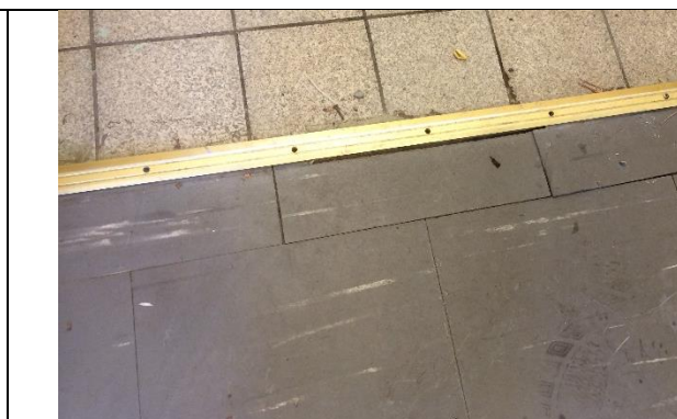
Bild 11: Prov 14 och 15, gråblå plastplattor och mattlim i VTD's lokaler plan 1. Ej asbest.
