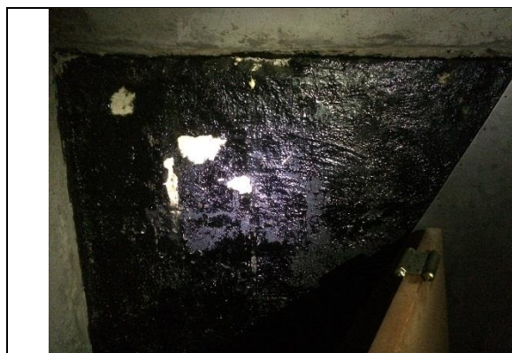
Bild 17: Prov 18, Tjärbeläggning vägg, butikskällare på källarplan. 110 mg/kg PAH.
