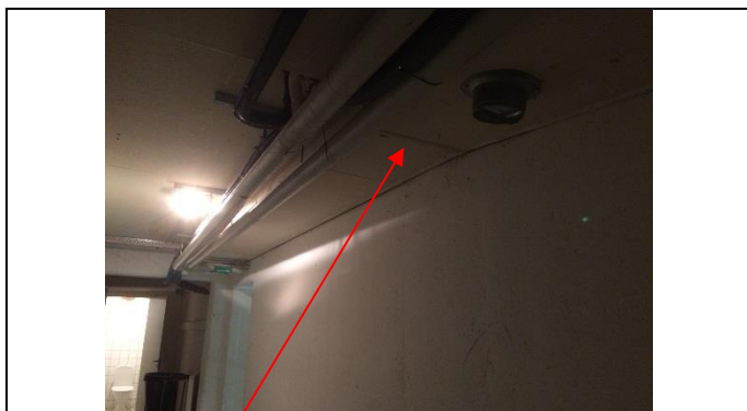
Bild 13: Provtogs 4, Kitt på ventilationskanal i passage/korridor på källarplan. Ej asbest.
