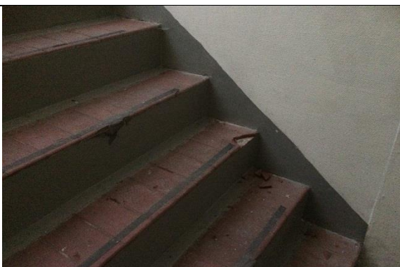
Bild 7: Prov 19 och 20, klinkerfog och -fix i trappa mellan källarplan och plan 1. Ej asbest.
