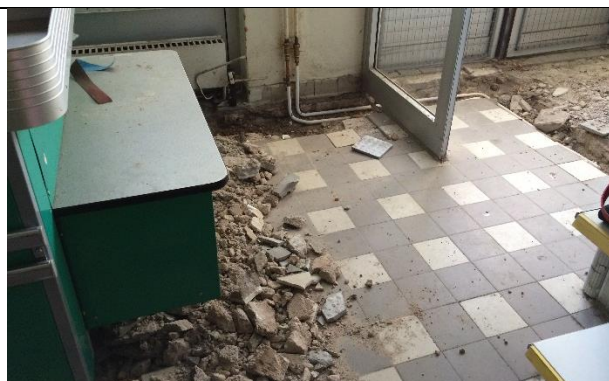
Bild 8: Prov 22 och 23, klinkerfog och -bruk i butikslokal på plan 1. Ej asbest.
