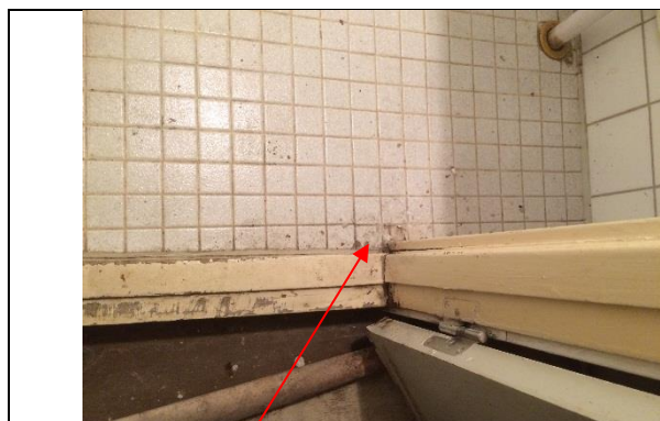
Bild 5: Prov 7 och 8, klinkerfog och -fix på WC på källarplan. Ej asbest.
